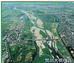
荒川大橋付近
