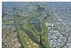
荒川第一調節池
