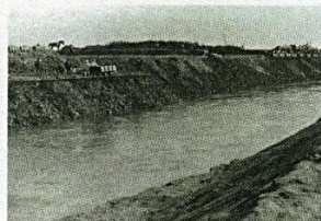
荒川改修工事(埼玉県さいたま市馬場付近) 堤防工事と併せて実施が行われ、工事には気動機車や馬車・トラックを使用している様子が見える。写真は、大正10年頃。
