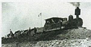
荒川改修工事(埼玉県さいたま市馬場付近) 気動機による工事の様子。工の運搬には3m3土運車が用いられ2.0~2.3台編成で運行された。
