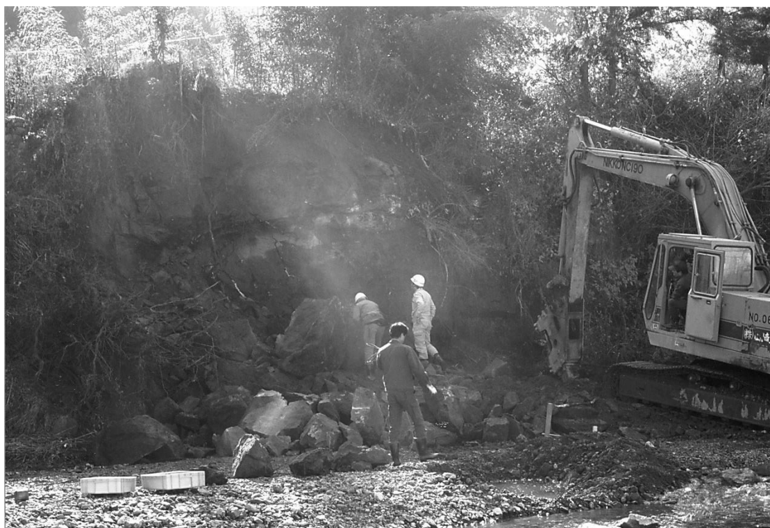
写真1 カキ化石産地における採掘作業 掘削には0.7t ブレーカを使用した。1991年12月7日撮影。
